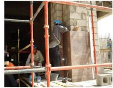
4 تثبيت الألواح فوق بعضها عن طريق البن المعدني
