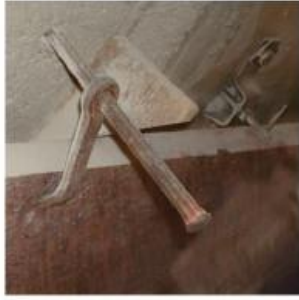
3 تثبيت اللوح علي الأرض وتثبيتته بالقمطة المعدنية أو الخشبية
