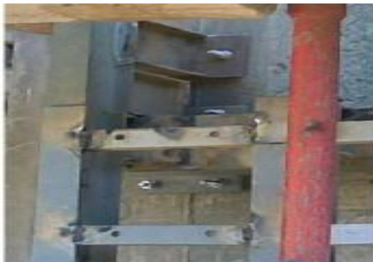
صور توضح طريقة التثبيت الشاسية في الخرسانة
