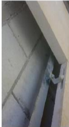
5 تفصيلية توضح تركيب الرخام علي الكانة
