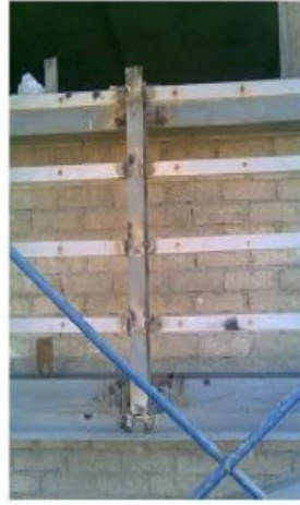
2 تفصيلية توضح لحامات اجزاء الشاسية
